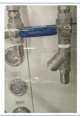
将冷水机的侧门打开,如下图所示会看见设备的Y型水过滤器。
